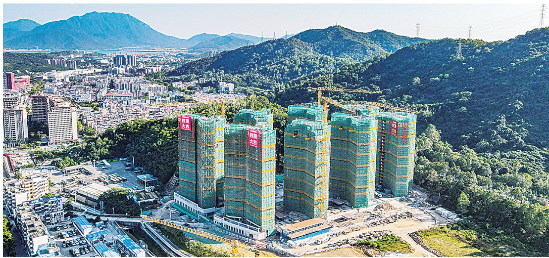
王母社区统建楼项目主体结构封顶。深圳侨报通讯员 李若石 摄
