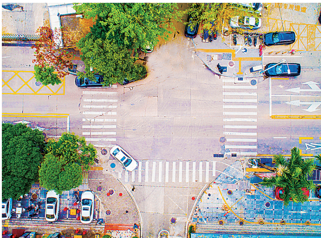
封闭路段。龙岗融媒记者 张臻斐 摄
