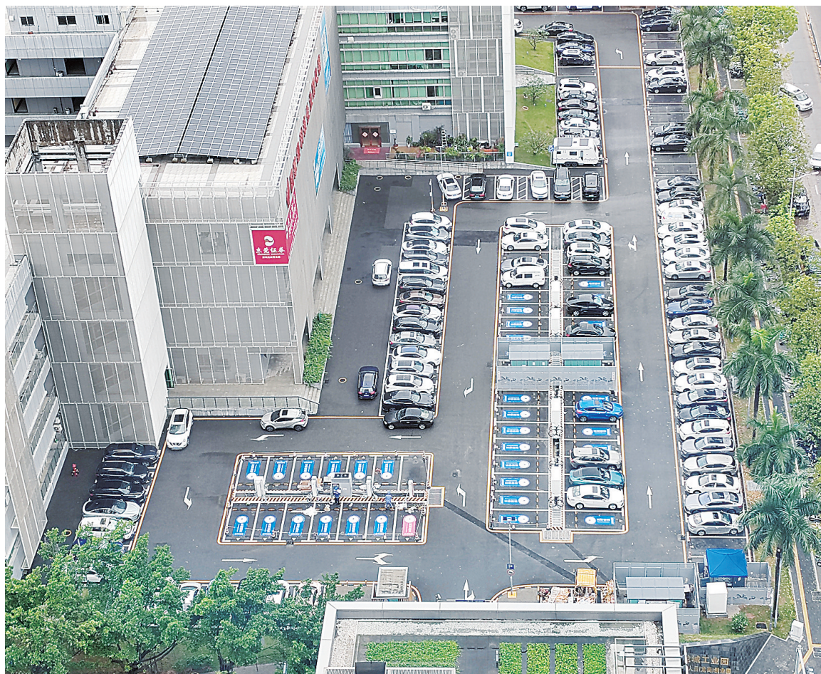
龙城街道首个“光储充”超充站在龙城工业园投入运营。
