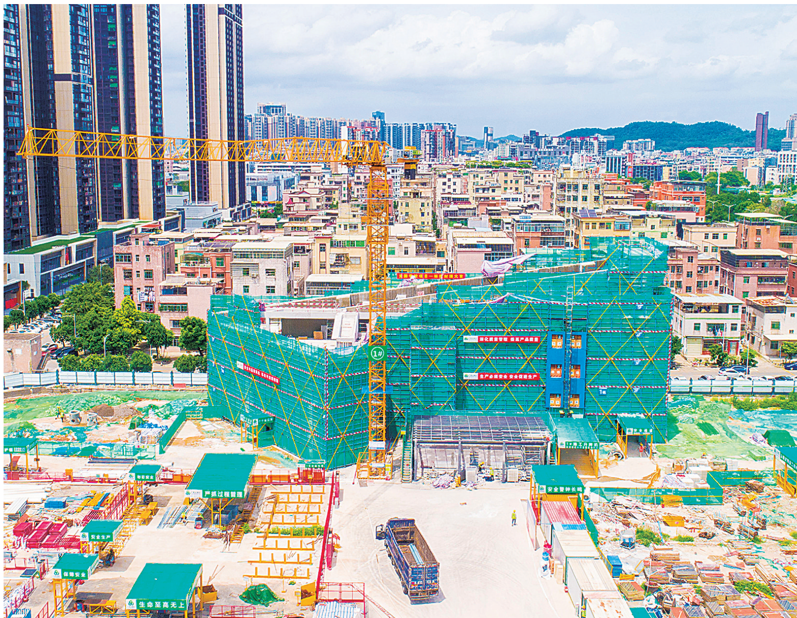
图为龙腾九年一贯制学校一标段封顶。龙岗融媒记者 张臻斐 摄
