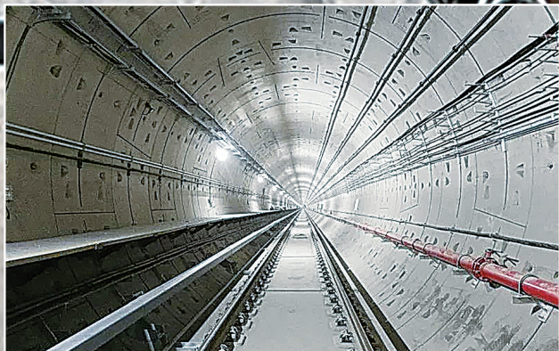
地铁3号线四期轨道。
