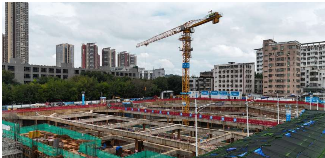
施工现场。龙岗融媒记者 何小娟 摄
