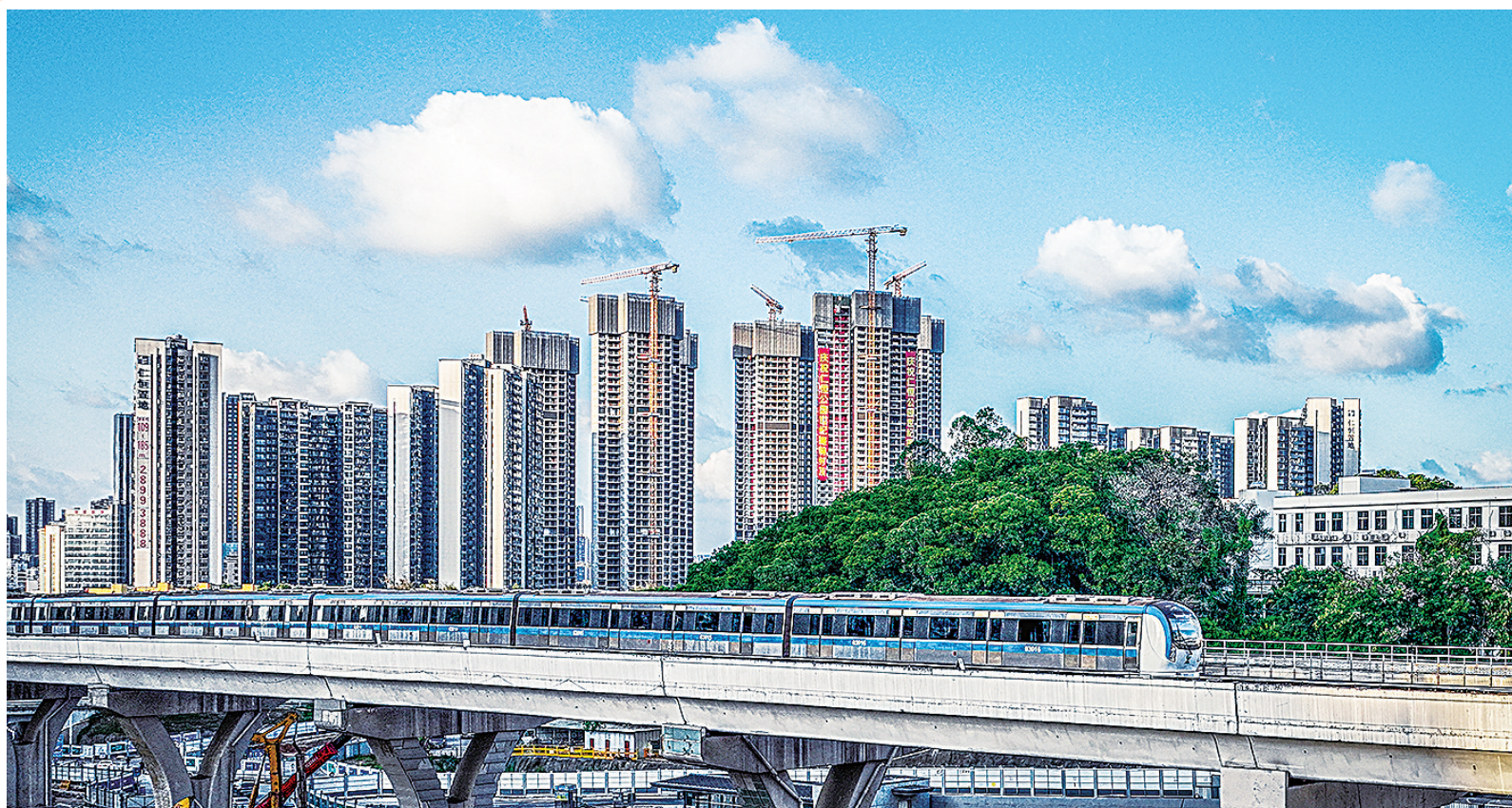
深圳地铁3号线。李凯摄
