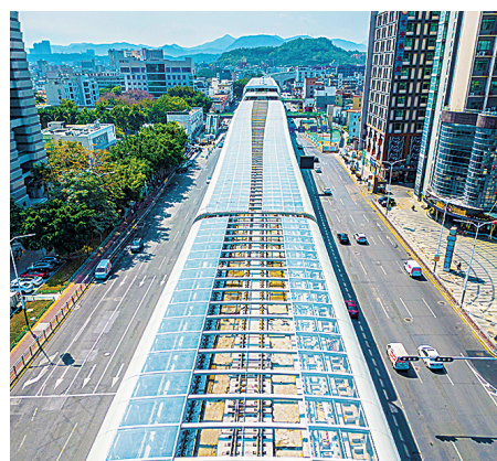
深圳地铁3号线四期建设现场。张臻雯摄
