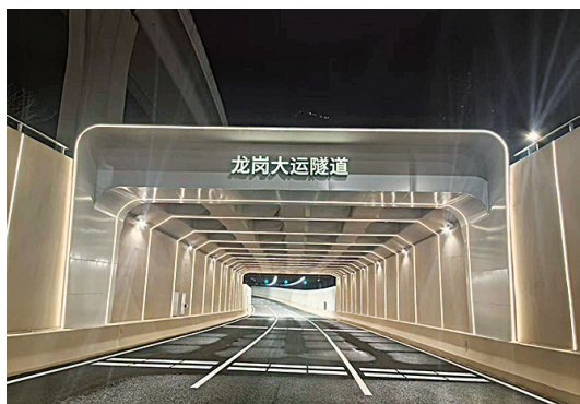
龙岗大道大运枢纽段下沉隧道。
