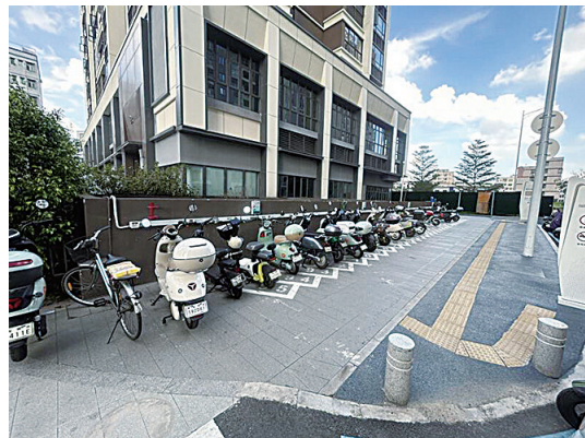
安全便捷的充电桩安装到位。
