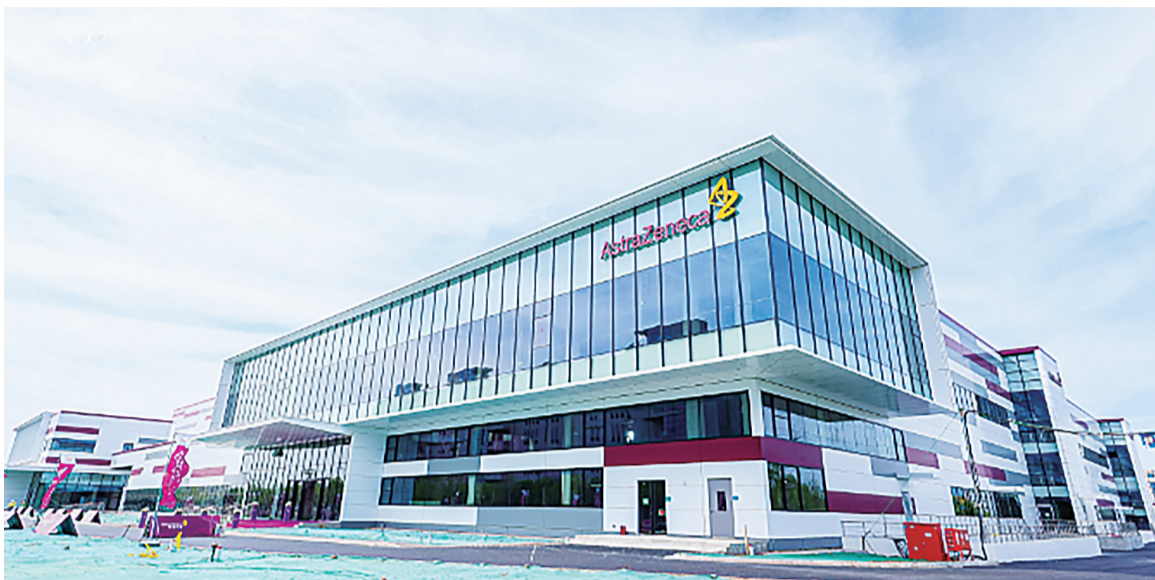
阿斯利康青岛吸入气雾剂生产供应基地一期建筑主体。
