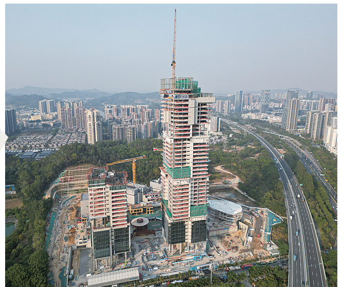
施工现场。龙岗融媒记者 张臻斐 摄
