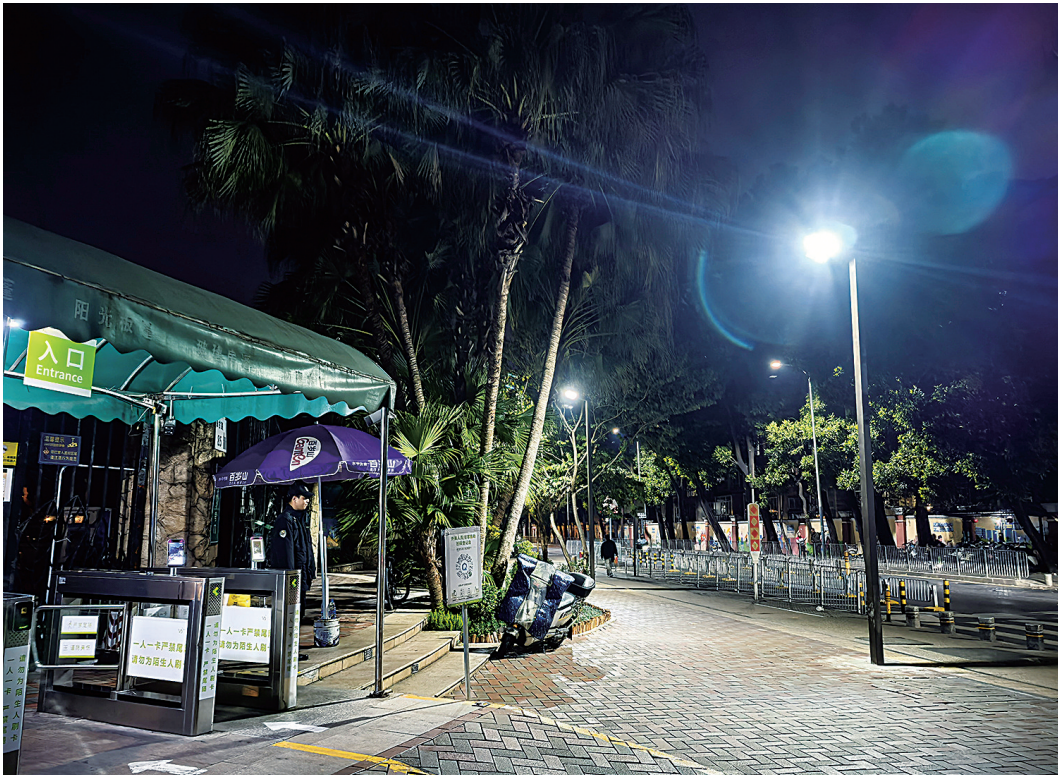
安装了新路灯的永香西路。受访单位供图
