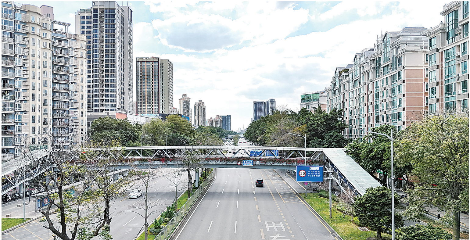
紫薇人行天桥升级改造,让市民“过街”变“悦行”。
