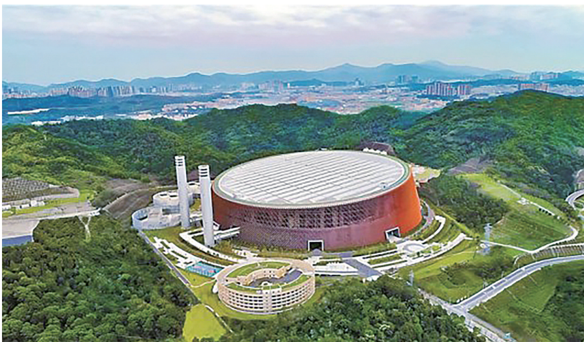
深圳龙岗能源生态园。
