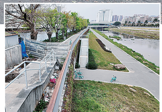
龙岗河干流碧道部分出入口处于封闭状态。
