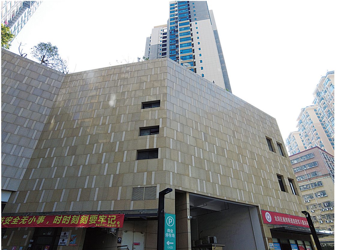
楼栋外墙修复工程已完工验收。
