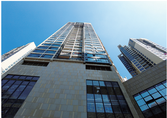
修复工程完工验收。
