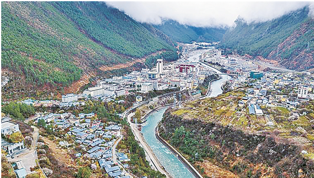
在深圳的助力下,察隅县建起了全新的办证大楼和县人民医院,以及相关的配套设施。
