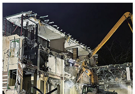
拆除现场。受访单位供图
