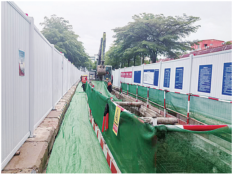
整改后的施工现场整洁有序。
