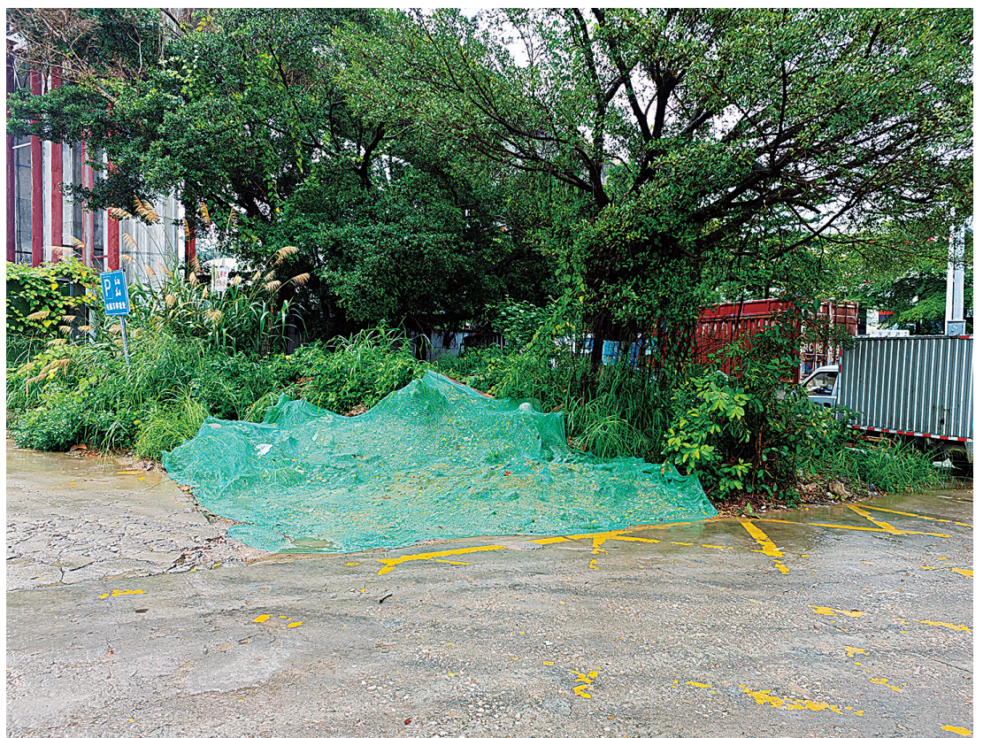
建筑垃圾清运完成，裸露黄土覆盖围挡。龙岗融媒记者 廖国鑫 摄
