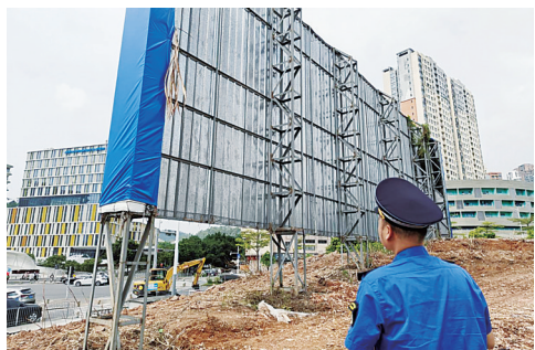
拆除现场。受访单位供图
